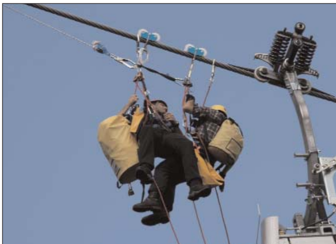
Der erste Retter eines Teams wird mit dem IMMOOS Doppellaufwerk Typ DC zur Kabine hinuntergelassen.
