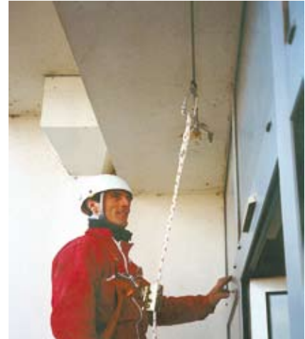
Montage an der Decke
