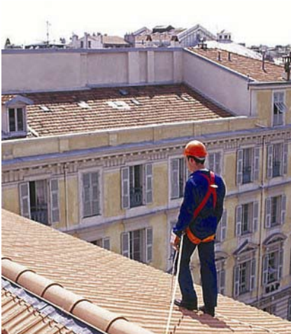
Montage am Dachfirst
