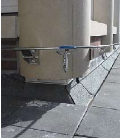
Montage an der Wand
